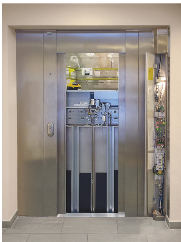
Palier avant solution modernisation (type 2)
